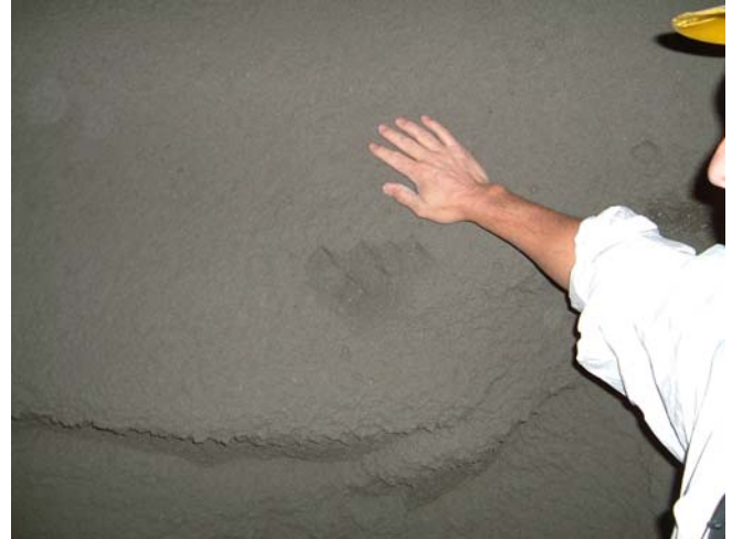
Figur 2 Laserstyrd automatiserad sprutning av betong (Hagerbach hösten 2005). Under handen (i det hackade hålet) mättes tjockleken till ca 10 cm. På den horisontella klacken (10-15 cm bred) i bildens nedre del är betongtjockleken 0 cm. Under klacken är det återigen tjockt med betong.
